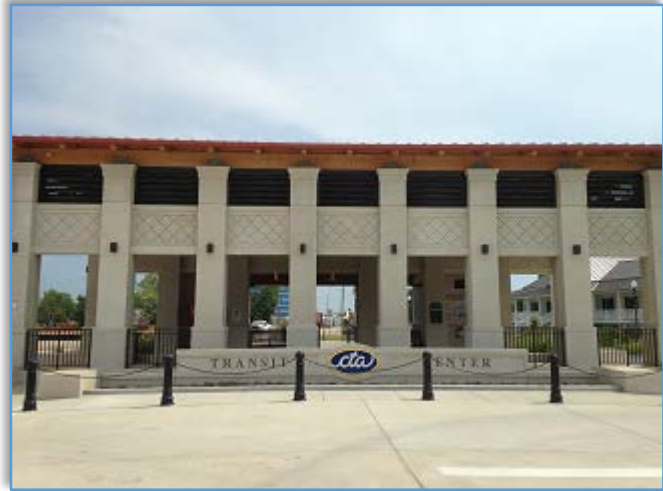
D'Iberville Transit Center on Central Avenue
